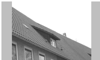
Dach mit neuer Gaube in der Okerstraße
