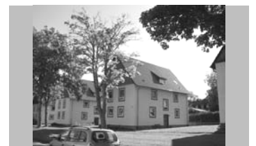
Neues Dach in der Hagenstr.
