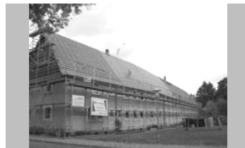
Dacharbeiten in der Okerstr. erfolgen noch an zwei Häusern
